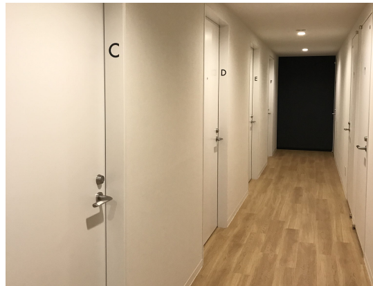
MGVunit 內的走廊 (左邊是房間，右邊是廁所及浴室)
